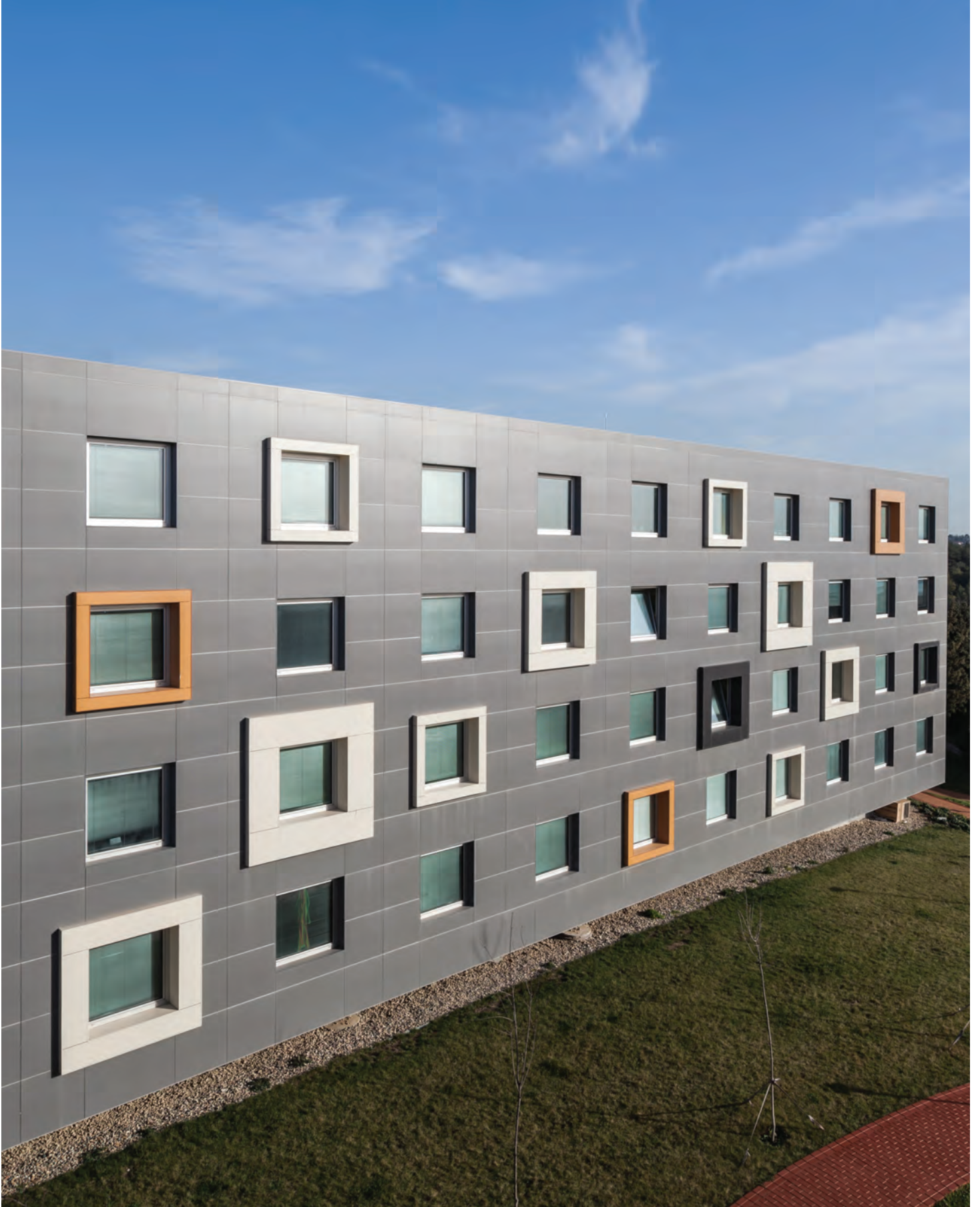
İTÜ Mezunlar Yurdu / İstanbul — Kalesinterflex 3mm Fit Mat Beyaz, 3mm Fit Mat Koyu Gri, 3mm Fit Mat Siyah, 3mm Fit Mat Turuncu / Gizli Klipsli Sistem İTÜ Dormitories / İstanbul — Kalesinterflex 3mm Fit Matte White, 3mm Fit Matte Dark Grey, 3mm Fit Matte Black, 3mm Fit Matte Orange / Hidden Clips Fitted Facade System Mimar: Hüseyin Kahvecioğlu, Nurbın Paker Kahvecioğlu, Melis Nur İhtiyar — Architect: Hüseyin Kahvecioğlu, Nurbın Paker Kahvecioğlu, Melis Nur İhtiyar
