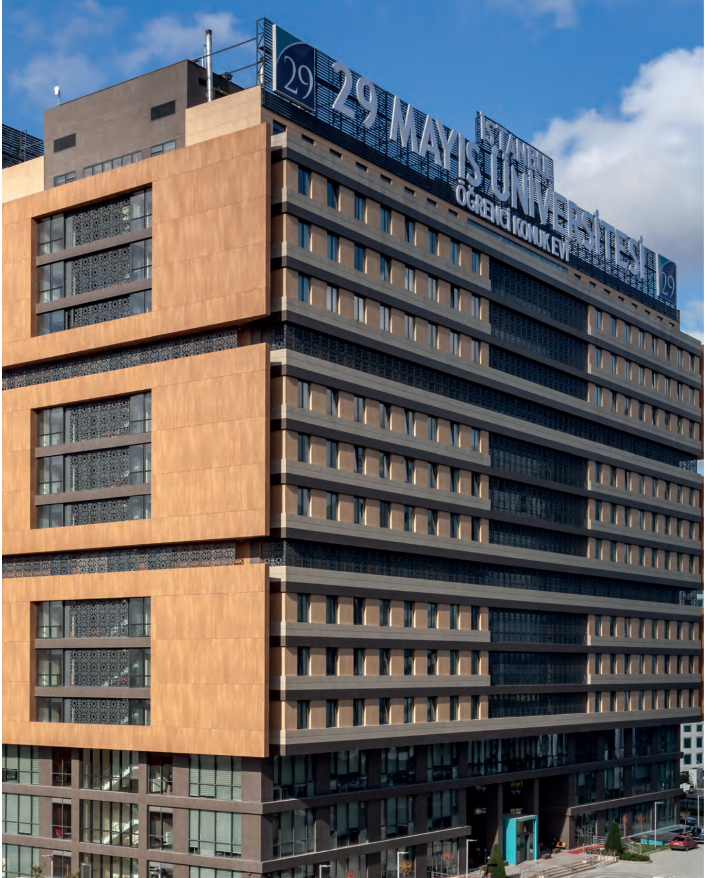
29 Mayıs Üniversitesi / İstanbul — Kalesinterflex 3mm Fit Luxury Cement Fildişi, 3mm Fit Luxury Cement Vizon, 3mm Fit Özel Ürün 29 Mayıs Üniversitesi Açık Ahşap, 3mm Fit Özel Ürün 29 Mayıs Üniversitesi Koyu Ahşap / Gizli Klipsli Sistem 29 Mayıs University / İstanbul — Kalesinterflex 3mm Fit Luxury Cement Ivory, 3mm Fit Luxury Cement Mink, 3mm Fit Special 29 Mayıs University Light Wood, 3mm Fit Special 29 Mayıs University Dark Wood / Hidden Clips Fitted Facade System Mimar: Zambak Mimarlık — Architect: Zambak Architectural Office
