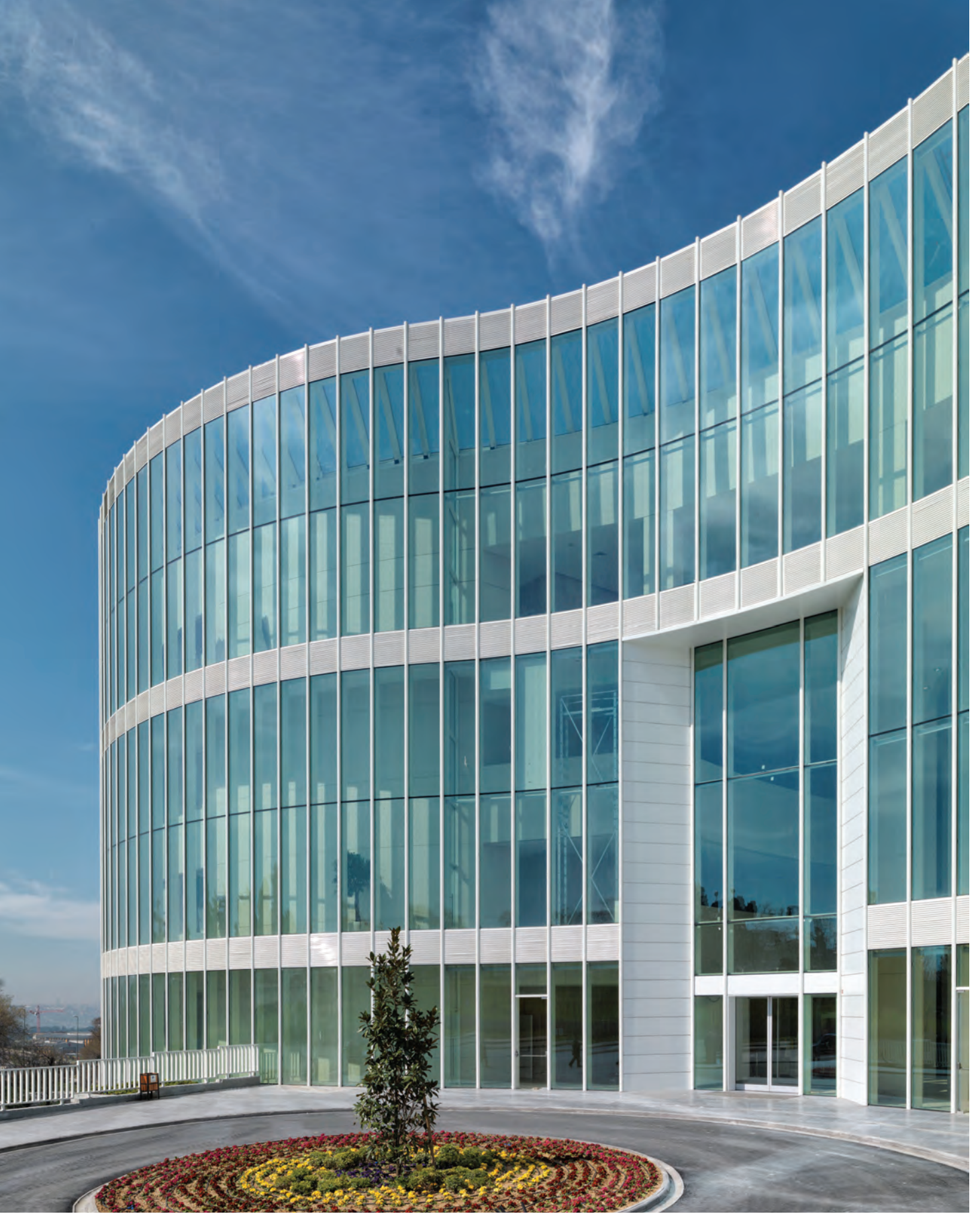
Küçükçekmece Belediyesi / İstanbul — Kalesinterflex 3mm Fit Mat Beyaz / Gizli Klipsli Sistem Küçükçekmece Municipality / İstanbul — Kalesinterflex 3mm Fit Matte White / Hidden Clips Fitted Facade System Mimar: Mutlu Çilingiroğlu Architects — Architect: Mutlu Çilingiroğlu Architects
