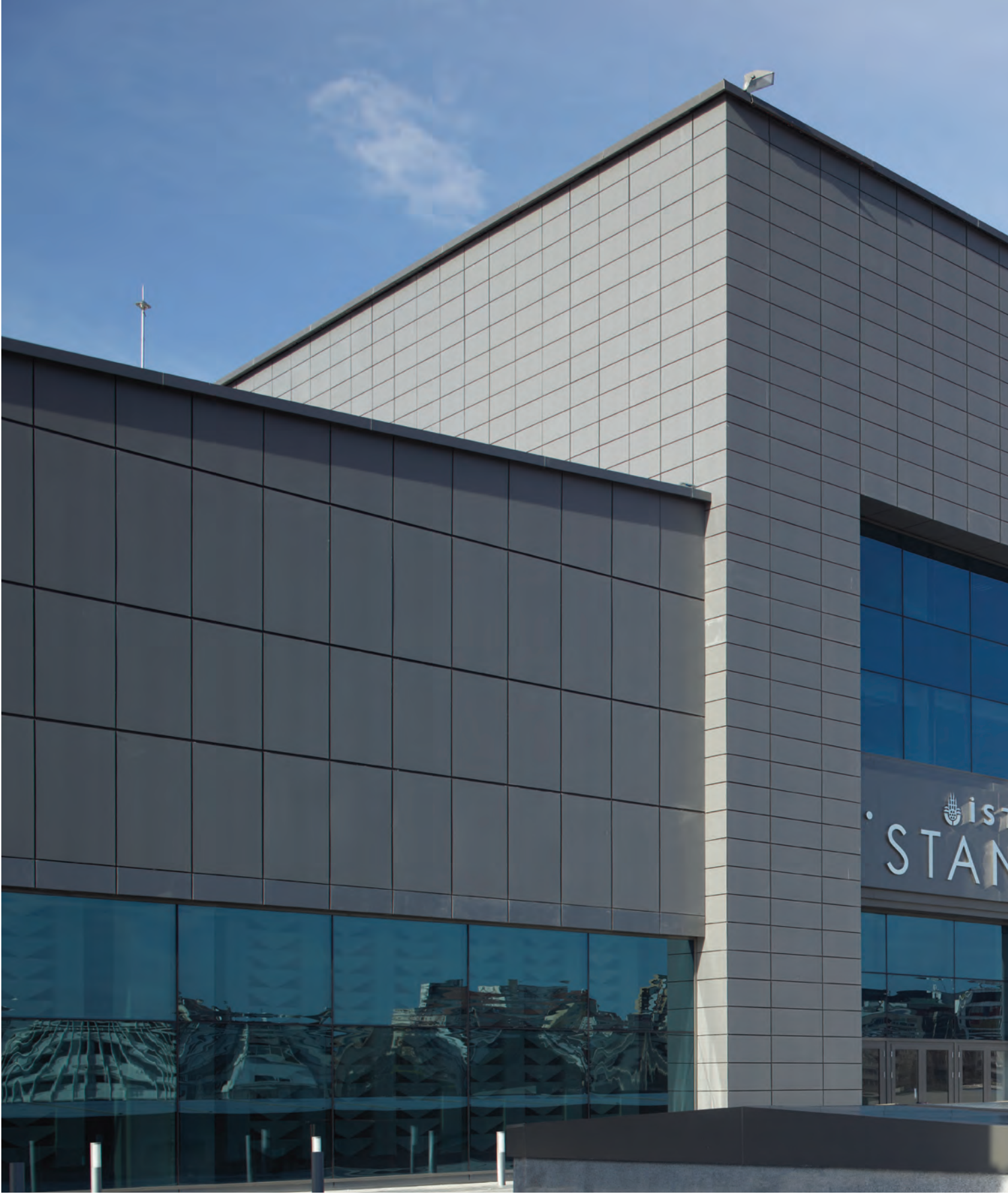
Lütfi Kırdar Kongre Merkezi / İstanbul — Kalesinterflex 3mm Fit Mat Özel Renk / Gizli Klipsli Sistem
